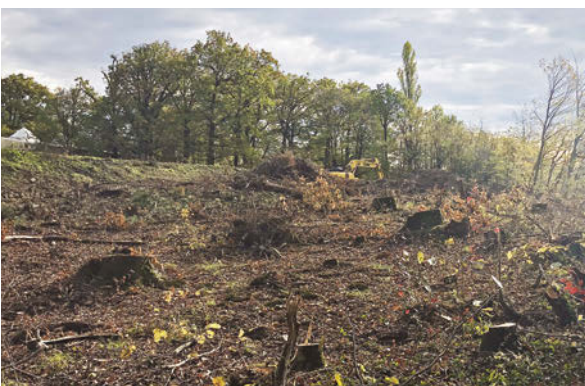
Umfangreiche Rodungsarbeiten auf dem zur Durchgangstraße abfallenden Gelände.
