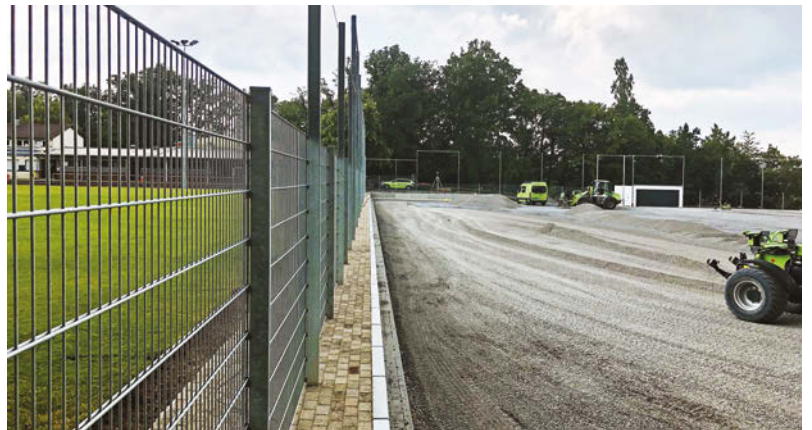
Einfassungen, Zaunanlage, Schottertragschicht – der neue Platz nimmt Formen an.
