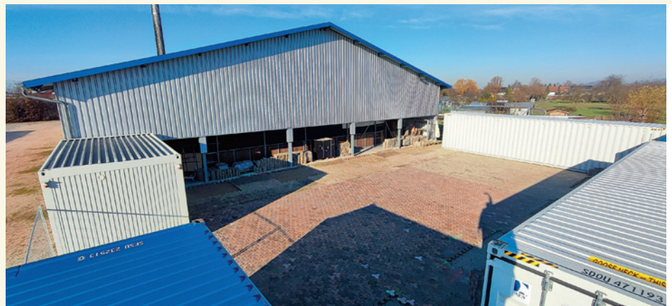
Erste Arbeiten in Sasbach sind bereits erledigt, der Belag und das Dach fehlen aber noch. Foto: Verein/Daniel Bühler
