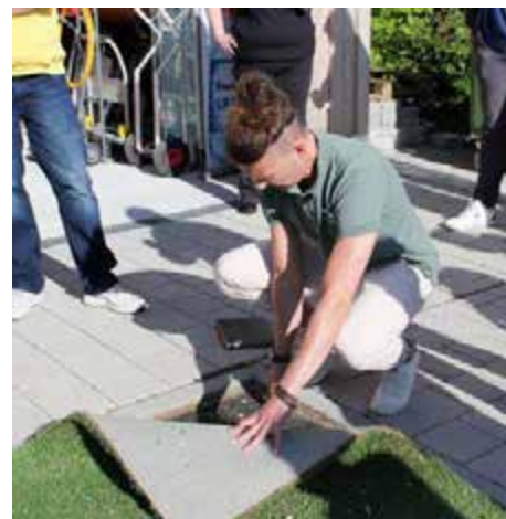
Daniel Schlupf (Polytan) zeigt die elastische Tragschicht unter dem Kunstrasen. Fotos: BSB Nord
