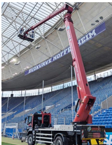
Die Umrüstungsarbeiten der Flutlichtanlage sowie der Tribünen- und Dachbeleuchtung des Stadions sind in vollem Gange.
