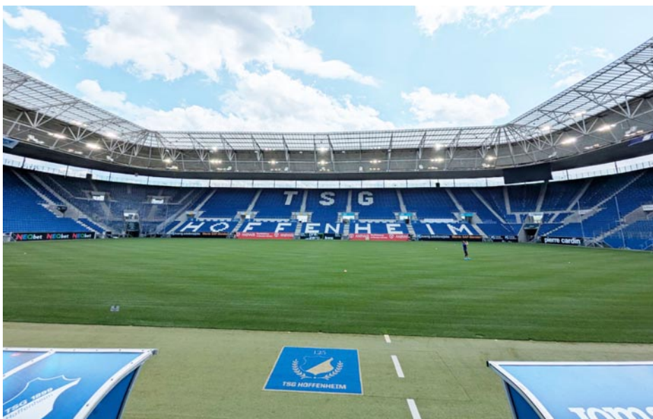
Die PreZero Arena der TSG Hoffenheim erstrahlt künftig in neuem Licht. Fotos: Kempff
