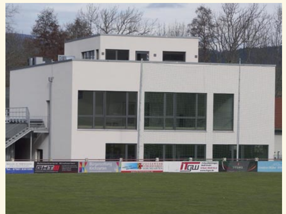
Der Anbau des neuen Trainingszentrums des SV Kirchzarten. Foto: Privat
