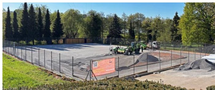
Einbau der Tragschicht als stabiler Unterbau für den Kunstrasen Foto: Garten-Moser
