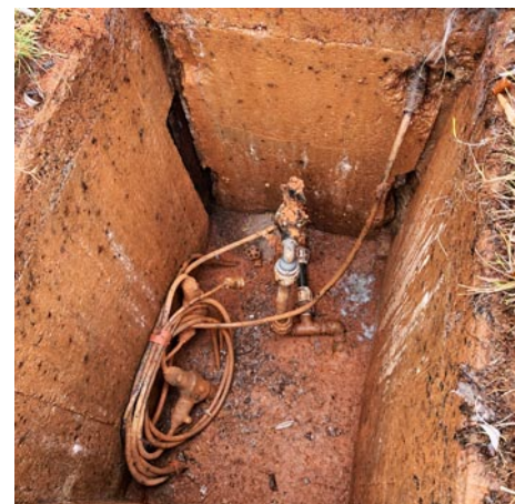
Rückbau der Beregnungsanlage Foto: Garten-Moser
