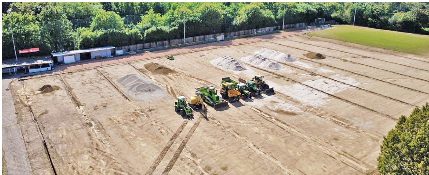
Der Hauptplatz des SV Hohenwettersbach mit neuen Drainagegräben und Sickerleitungen. Fotos: Garten-Moser
