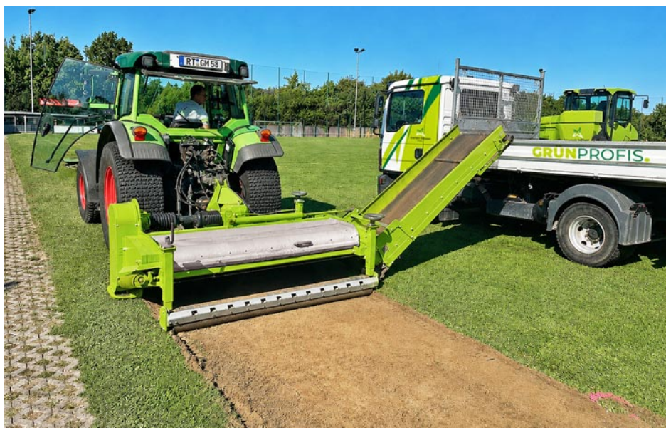
Abfräsen von insgesamt 8 cm stark wasserundurchlässigem Material.
